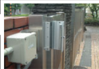
【電磁石錠】+【制御盤】
